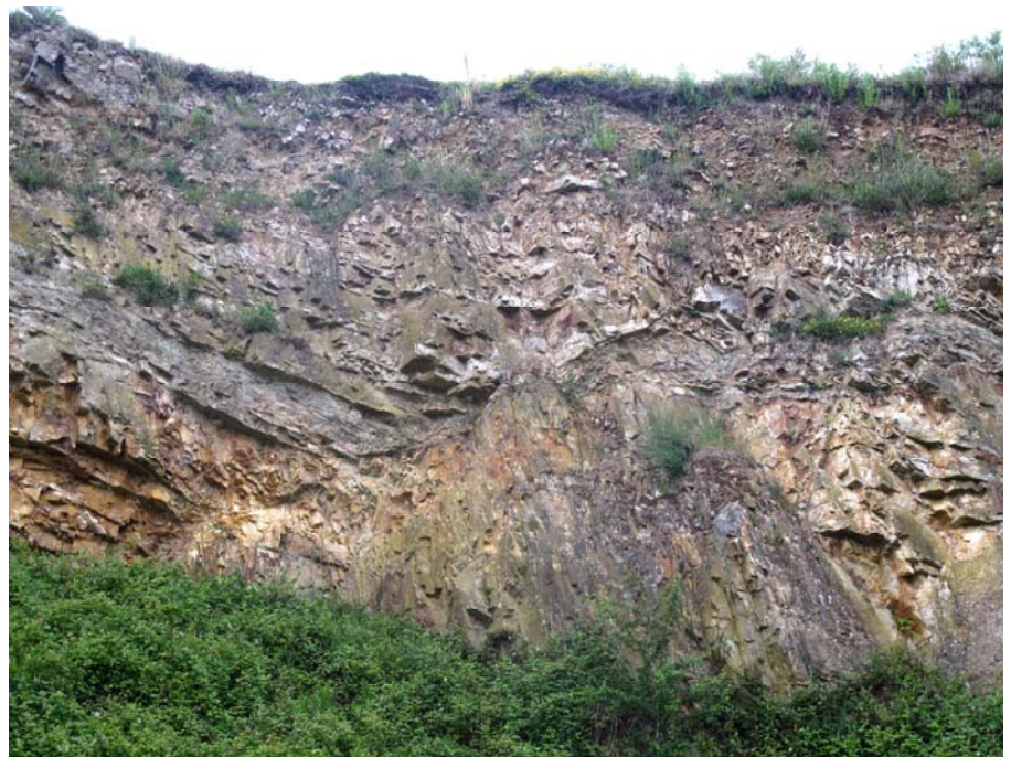
Cisaillement inverse plat dans la partie ouest de la carrière (© L. BAILLET)
