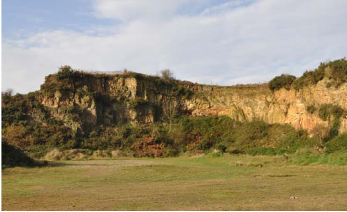
Partie ouest du front de taille : zone instable à gauche et zone très fracturée à droite (© L. DUPRET)
